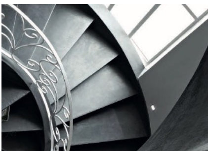
Portaat Elämyslattia+ mikrosementillä pinnoitettuna
